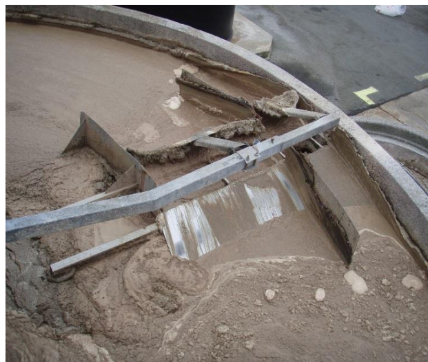
Figure 28 : Graisse de flottation
