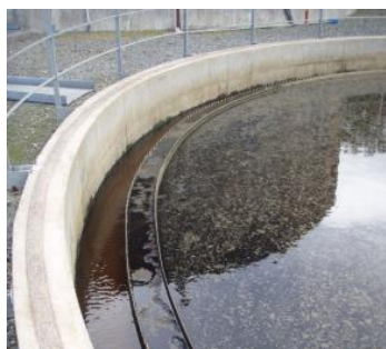
Figure 27 : Bassin nitrification dénitrification avec décantation
